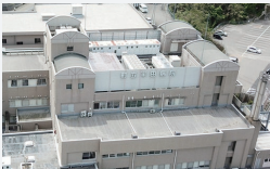
つるぎ町立半田病院
