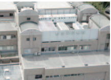
つるぎ町立半田病院
