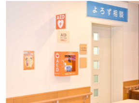
1階総合受付横に設置の1台
